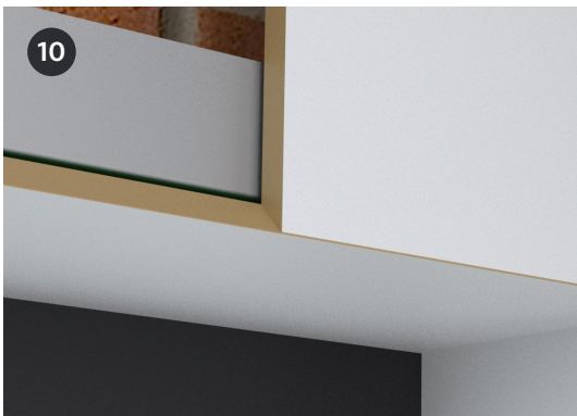
Raamafwerking verstek paint / paint
